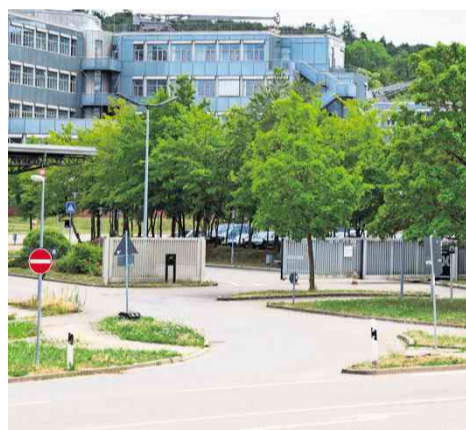
Derzeitige Bestandsgebäude F: EER/Silas Schüller
